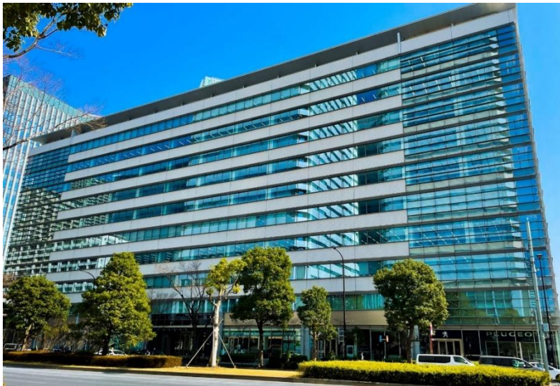
晴海センタービル
